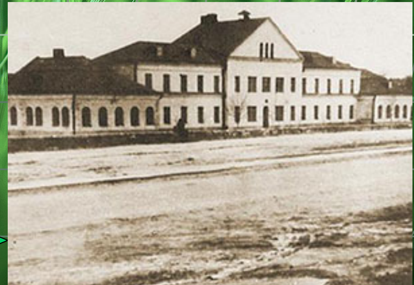
Нинішній навчальний корпус №3 (1934-1954 рр.)
