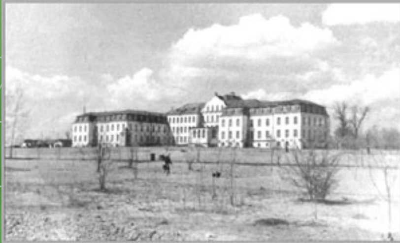
Будівництво навчального корпусу № 4 (1927 рік)
