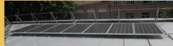
Фотоелектричні перетворювачі KV-180/24M на даху навчального корпусу №8 Photovoltaic cells KV-180/24M on the roof of education building №8
