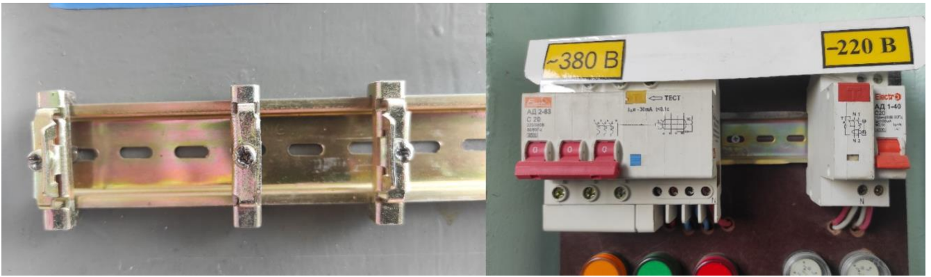
Рисунок 1 – Кріплення автоматичних вимикачів на DIN-рейку
