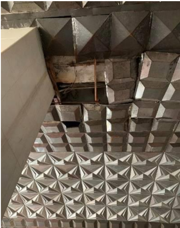
Рис. 1. Замокання елементів перекриття та підвісної металевої стелі на першому поверху, корозія сталевих елементів кріплення стелі, внаслідок протікання інженерних мереж в осях «Б - В», «7 - 8»
