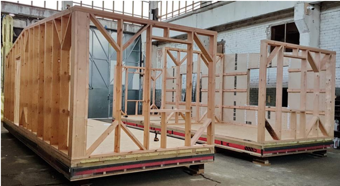
Рис. 1. Дерев'яний каркас модульного будинку
