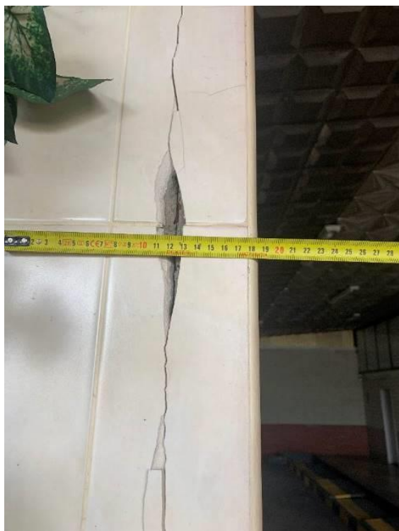
Рис. 2. Вертикальна тріщина по колоні перерізом 400 х 600мм на 1 поверху приміщення гаражу на перетині осей «8», «Б» з шириною розкриттям 1,0-3,0 мм, довжиною 1,37 м: а) – за результатами обстеження 2016 року; б) – теж саме 2021 року.
