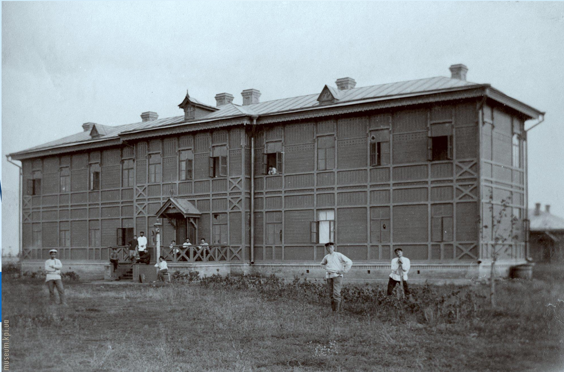
Будівлі садиби Затиш'є (гуртожиток) (1902 р.)
