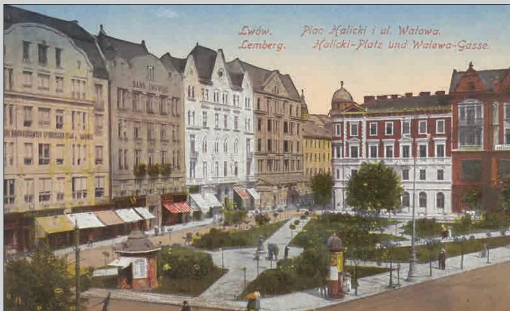
Вулиця Валова і площа Галицька у м. Львові. Прибуткові будинки поч. ХХ ст. у стилях сецесії, історизму, конструктивізму. Будинок на розі з куполом споруджений 1888 р. для русофільського «Общества ім. М. Качковського». Арх. Вінцентій Кузневич. Поштівка ( Kraków: Sztuka , 1918). Національна бібліотека / Biblioteka Narodowa , м. Варшава, Польща. Poczt. 119
