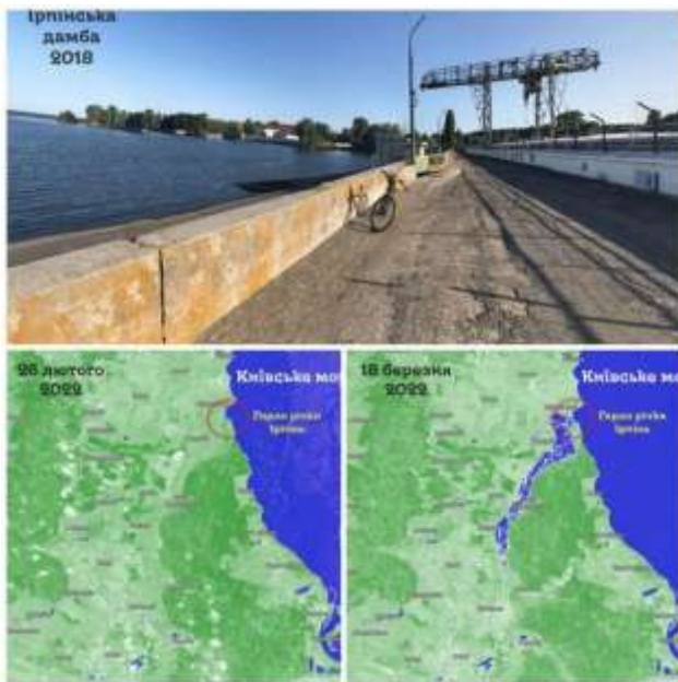
Рис. 1. Ірпінська дамба (Київська обл., права притока р. Дніпро) [4]
