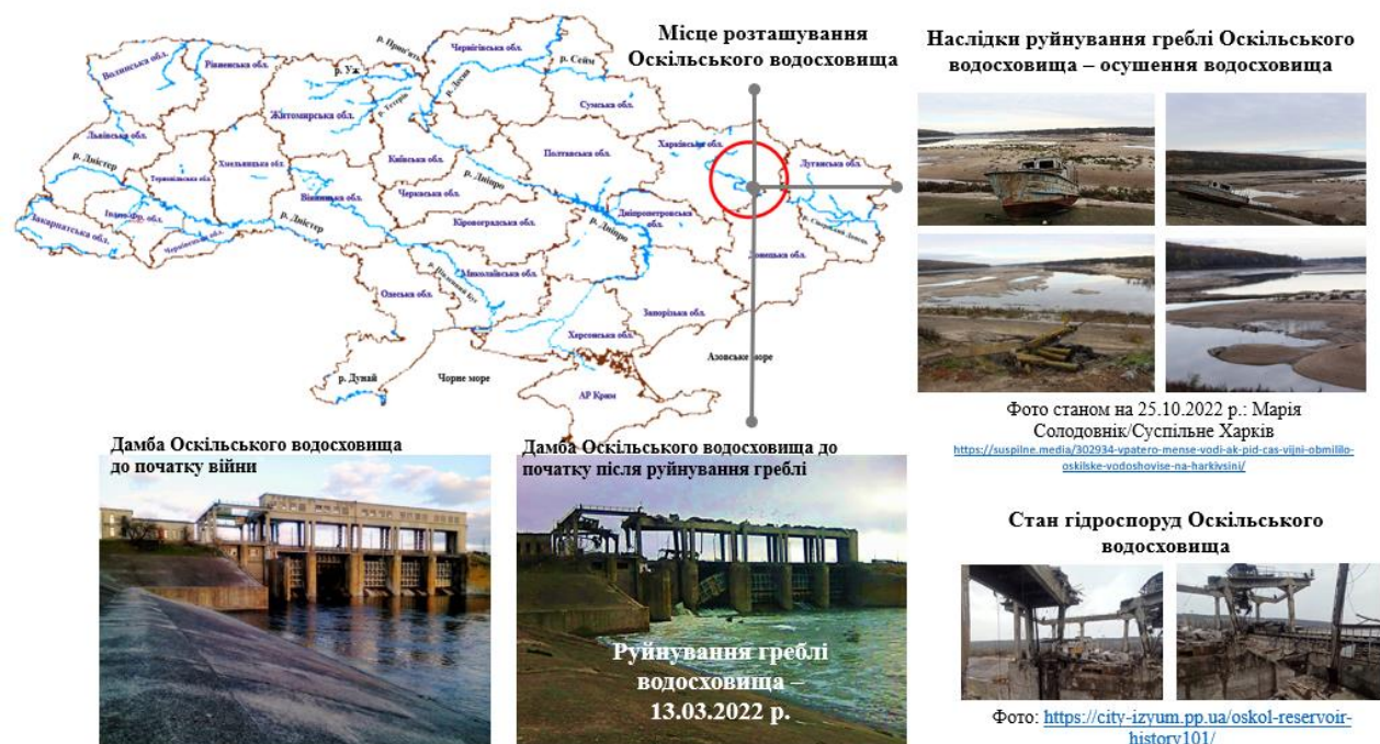
Рис. 2.20. Інфографіка руйнування греблі Оскільського водосховища в Харківській області (власна інтерпретація даних В.П. Строкаль; інформацію підготовлено на основі літературних джерел [62-64])
