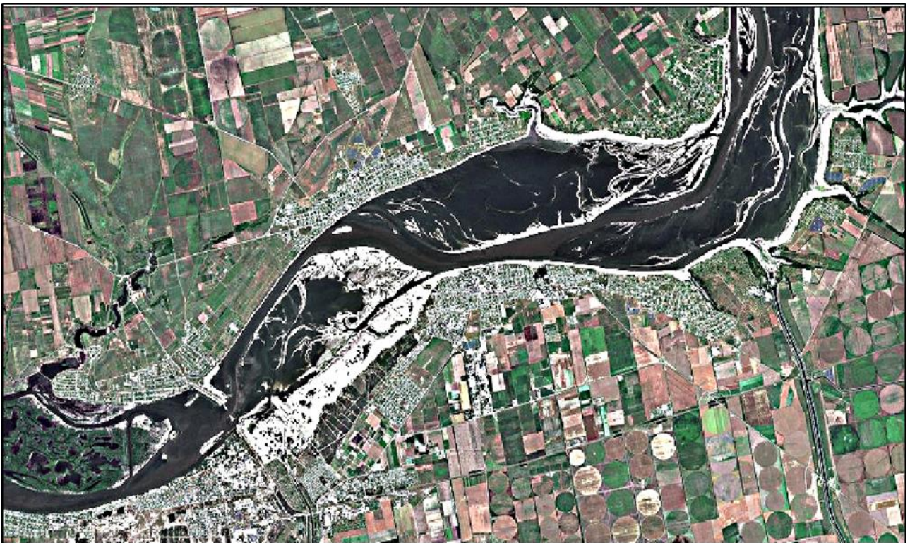
Рис. 2.28. Нижня частина водосховища та зруйнована ГЕС [105]
