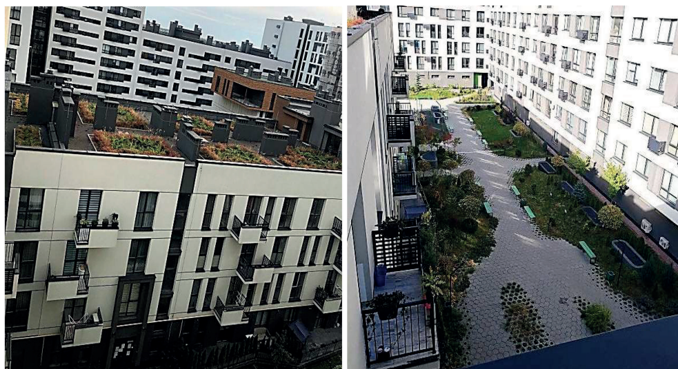
Рис. 4. Сад на даху висотної будівлі (зліва) та на перекритті підземного паркінгу (фото О. Галевич)
