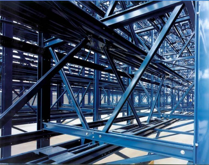
Рис. 9. Конструктивне рішення висотних стелажів
