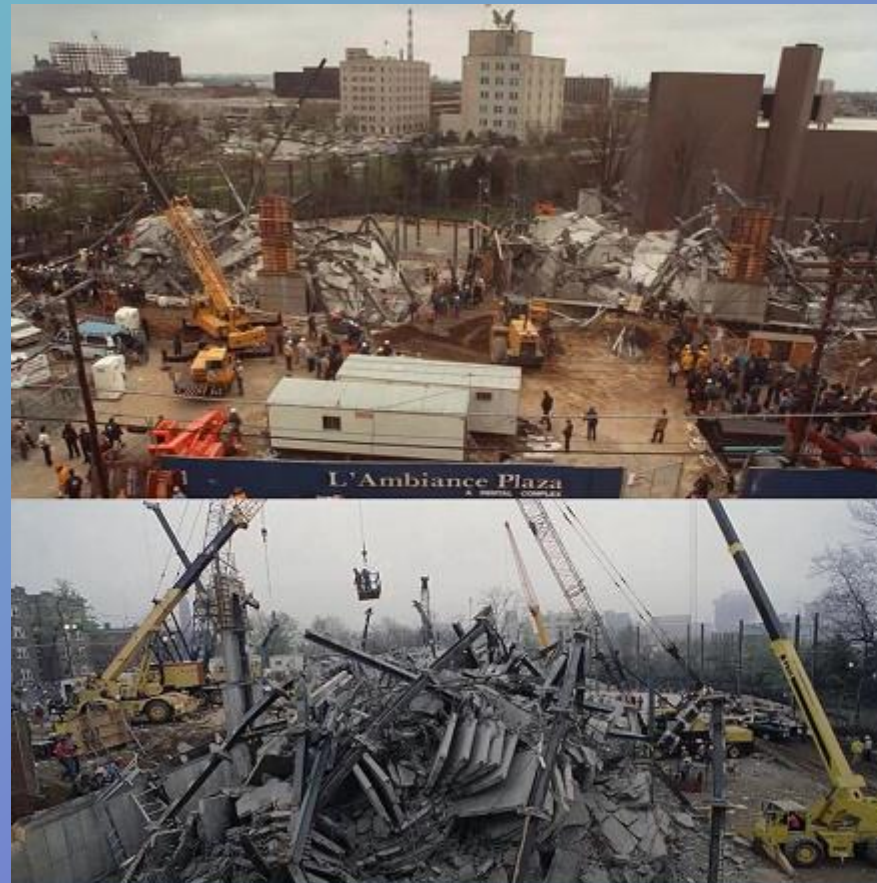
Рис. 16 Приклад руйнування частини багатоповерхового житлового будинку “L'Ambiance Plaza” внаслідок прогресуючого обвалення на стадії монтажу у 1987 році в США
