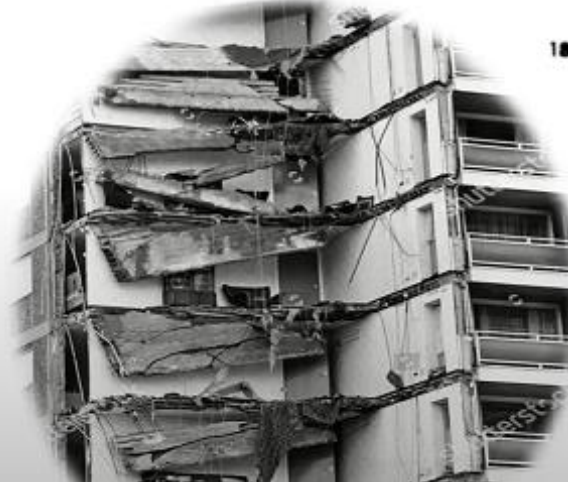
Рис. 14 Приклад руйнування нового багатоповерхового житлового будинку “Ronan Point” внаслідок прогресуючого обвалення (причина – вибух газу в одній із квартир) у 1968 році в Англії
