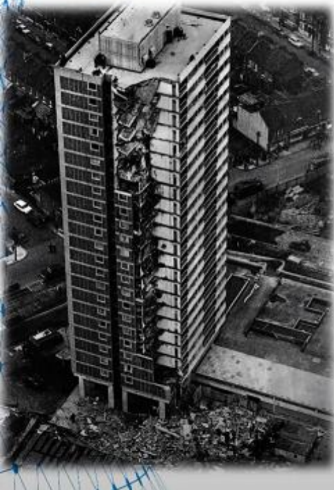
Рис. 14 Приклад руйнування нового багатоповерхового житлового будинку “Ronan Point” внаслідок прогресуючого обвалення (причина – вибух газу в одній із квартир) у 1968 році в Англії
