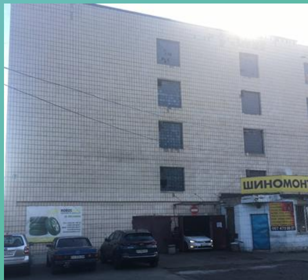
Рис. 12 Фрагмент фасаду будівлі гаража по осі «А» в осях «20–27»
