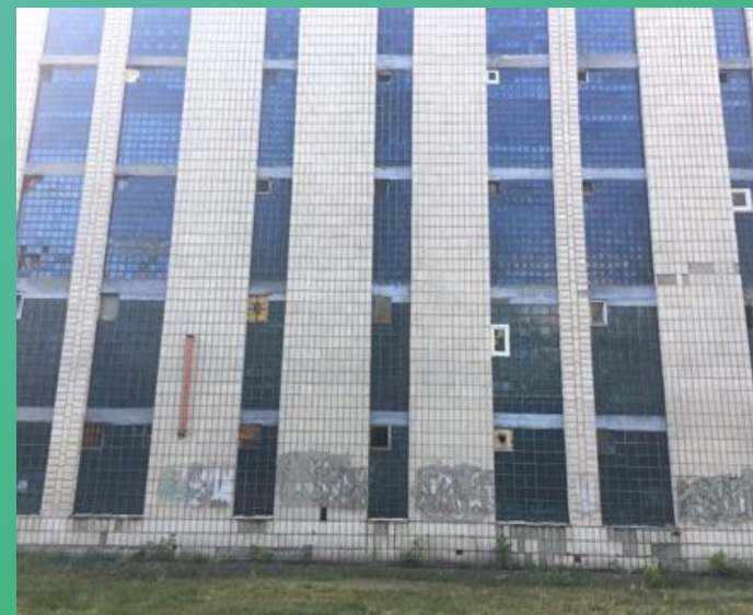
Рис. 13 Фрагмент фасаду будівлі гаража по осі «А» в осях «20–27»
