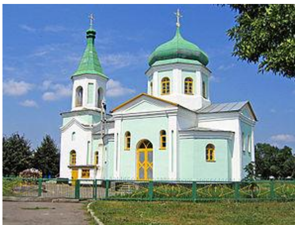
Рис. 1. Будівля Свято-Троїцької церкви в с. Овсюки
