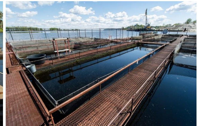
Рис. 3. Понтони із металевої конструкції
