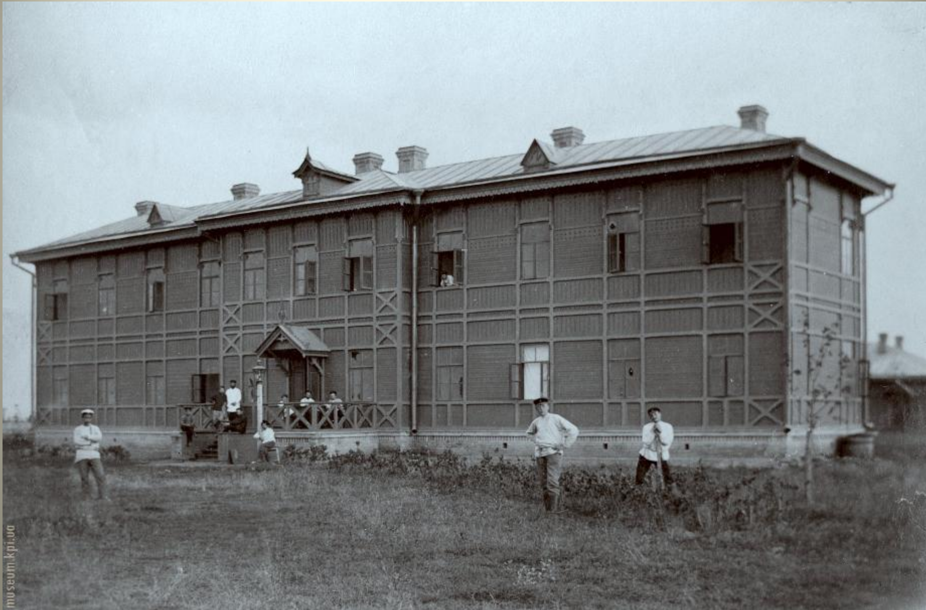
Будівлі садиби Затиш'є (гуртожиток) (1902 р.)
