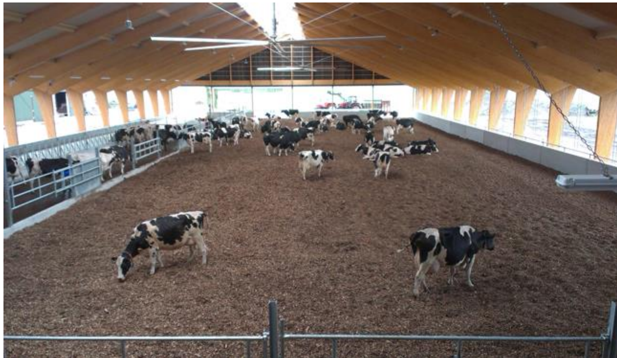
Рис. 1.2.12. Класичний вид компостного корівника (СДВ) в якому застосовується поверхнева аерація підстилкового матеріалу. Ліворуч на світлині алея перед кормовим столом та кормовий стіл, вгорі дах обладнаний світло аераційним елементом з системою примусової вентиляції (Нідерланди, 2018 р.).
