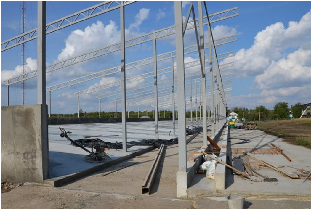
Рис. 1.2.5. Фрагмент будівництва напіввідкритого приміщення для утримання телиць на накопичувальній підстилці з схилом зони відпочинку до алеї перед кормовим столом (ТОВ «Кишенці» Маньківського р-ну Черкаської обл.; власник Корнеліс Хузінха).
