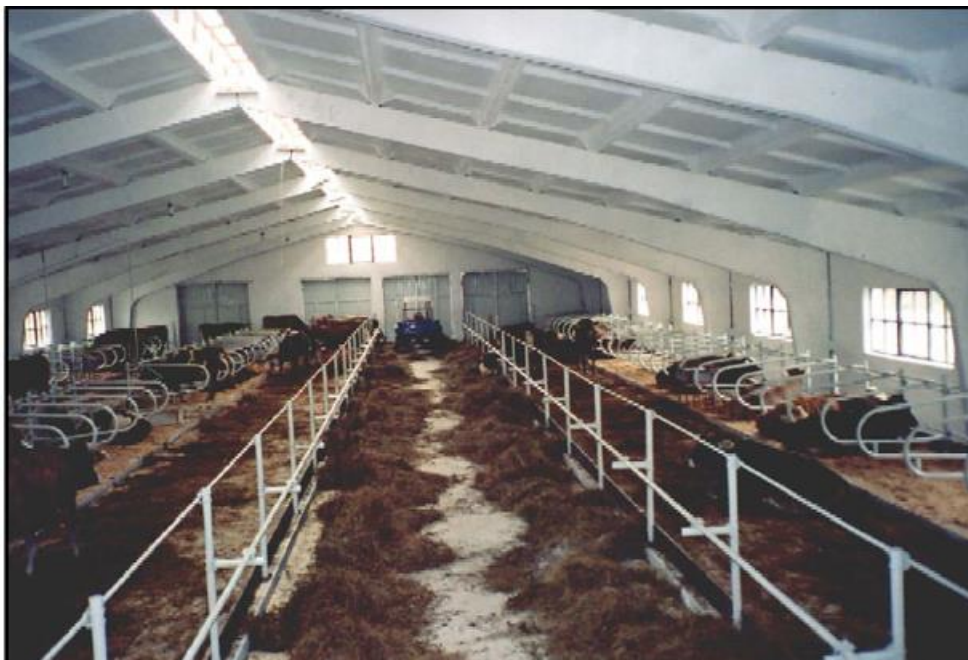
Рис. 1.1.9. Загальний вид корівника на 90 корів у приміщенні із залізобетонних конструкцій типу РПС (республіка Вірменія, ферма „Dili farm” 2006 р).
