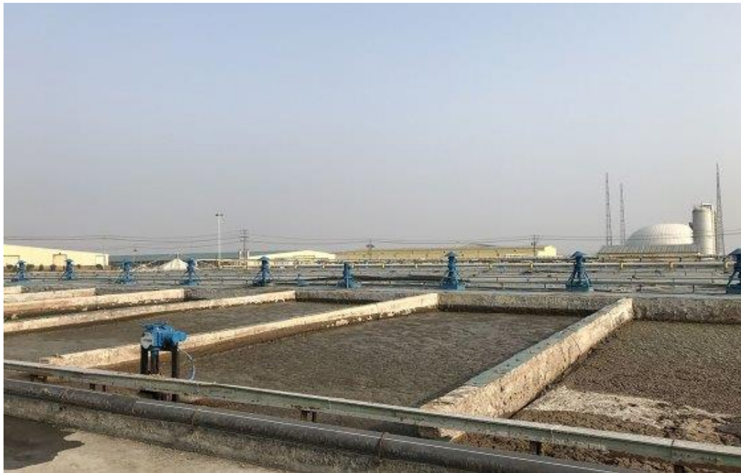
Рис. 1.3.15. Лагуни для зберігання стічної маси з метантенків для виробництва біогазу ферми на 20000 корів? яка „викидає” біля 3000000 літрів відходів у вигляді рідкого гною щодобово! (Китай).
