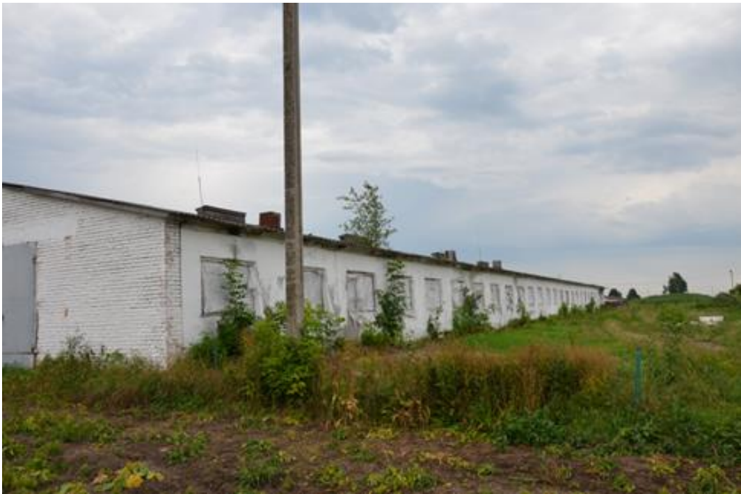
Рис. 2.1.4. Вид приміщень арочного типу зі сторони вигульних майданчиків.
