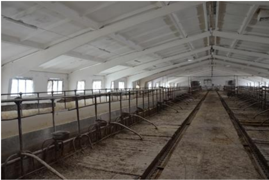
Рис. 2.1.6. Загальний вид виробничих приміщень арочного типу які підлягають реконструкції.
