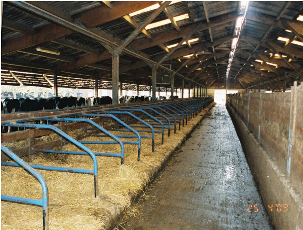
Рис. 1.1.8. Спрощений варіант конструктивного рішення боксів для корів в приміщенні полегшеного типу (ферма Mezy garda – Угорщина, квітень 2003, утримувалось – 1500 корів голштинської породи, добовий надій – 35 літрів на корову, вміст жиру – 3,80%, білка – 3,20%).
