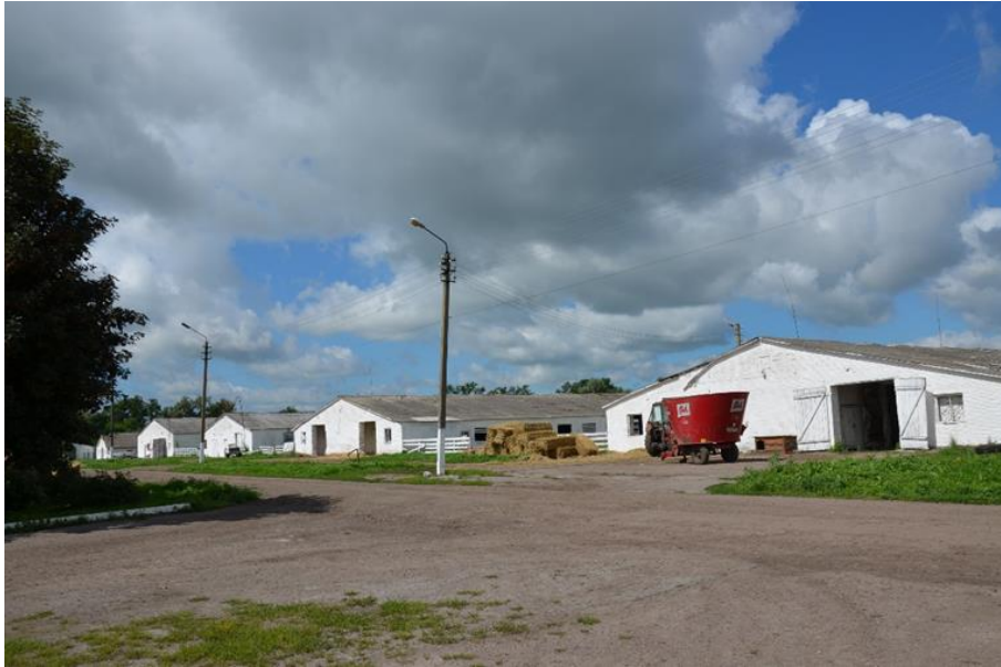
Рис. 3.1.3. Загальний вид виробничих приміщень які підлягають реконструкції зі сторони під'їзних шляхів.
