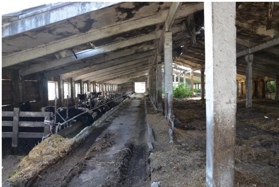
Рис. 3.1.7. Внутрішній вид приміщення опорного типу яке підлягає капітальній реконструкції (4-позиція, на рис. 3.1.2).
