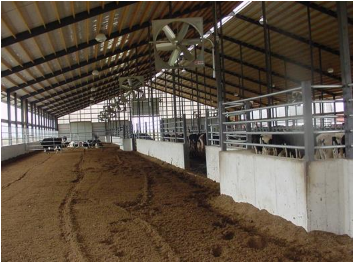
Рис. 1.2.7. Зона накопичувальної підстилки, після застосування аерації в приміщенні CDB (від англ. Compost dairy barns – компостний корівник), Вісконсін США, 2015 рік.
