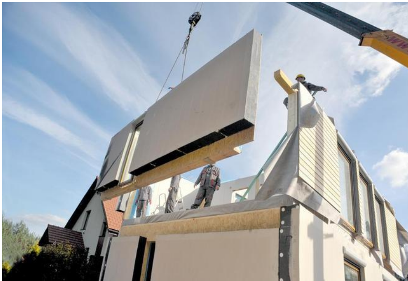
Рисунок 2 – З'єднання при монтажі модульного будинку
