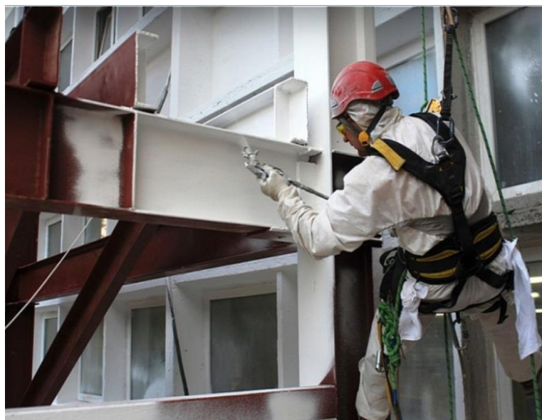
Рисунок 2 – Нанесення фарби на металеву конструкцію
