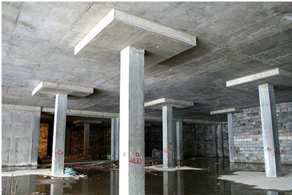
Рисунок 1 – Підсилення колон за допомогою капітелей
