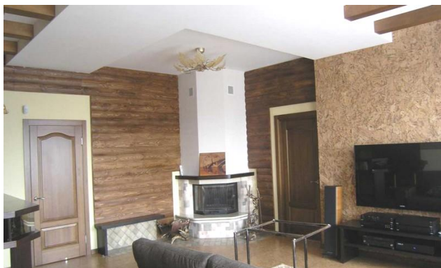
Рисунок 2 – Оздоблення стін з рулонної пробки
