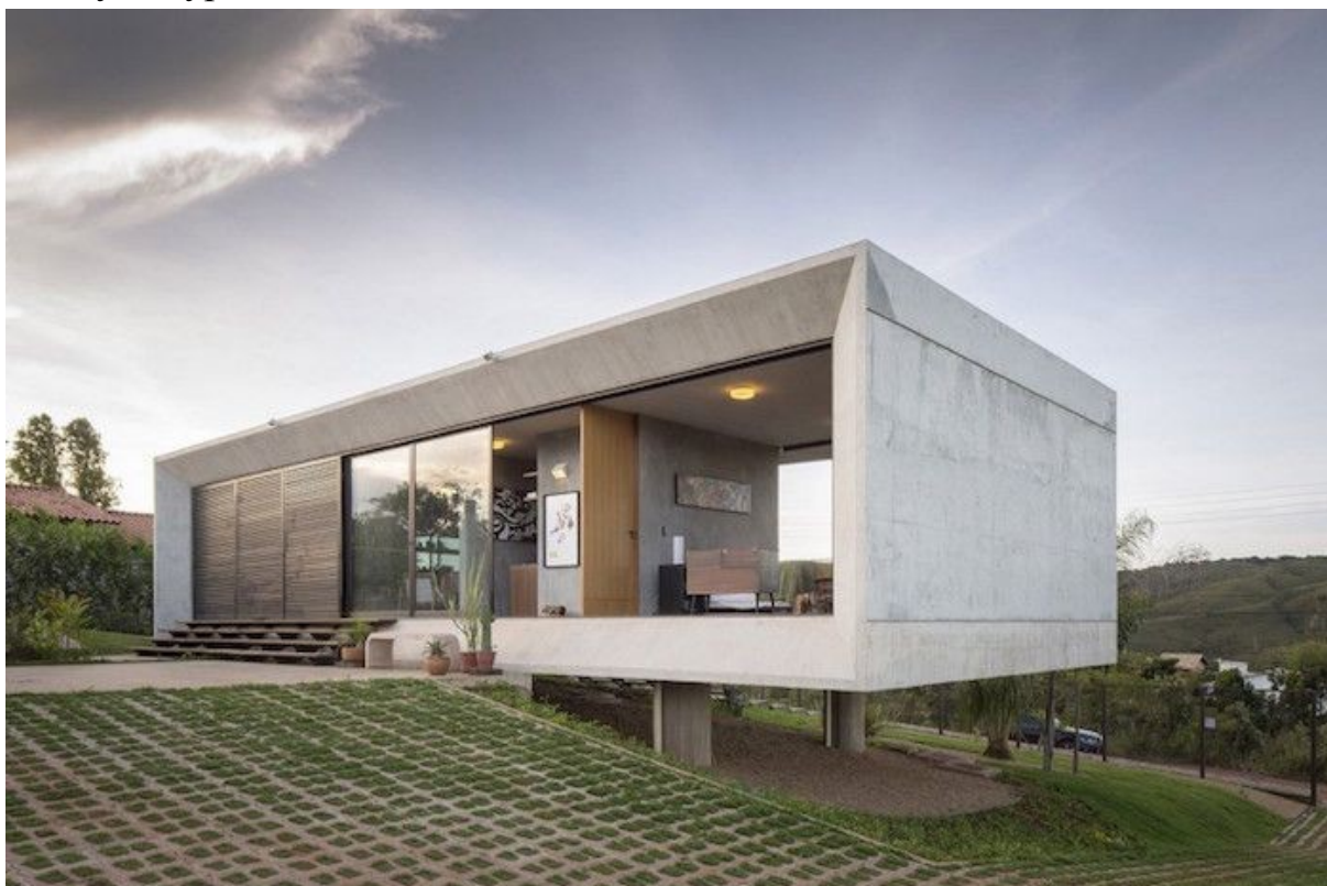
Рис. 5. Монолітна будівля на схилі
