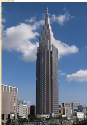
Офис NTT (Nippon Telegraph and Telephone) (Токіо)
