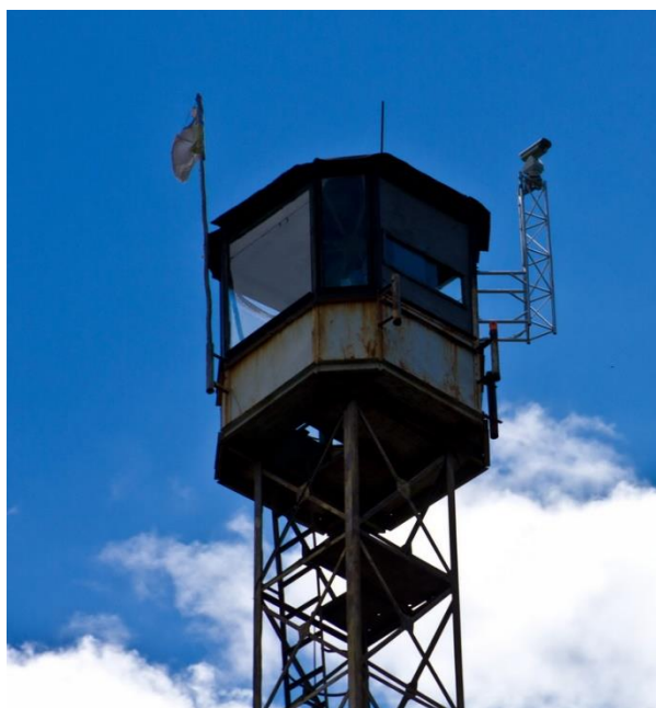
Фото 141. Зовнішній вигляд пожежно-спостережної вежі, в якій знаходився спостерігач до моменту встановлення камери. Камера прикріплена на кронштейні вище будки справа. Камера працює цілодобово протягом пожежонебезпечного періоду
