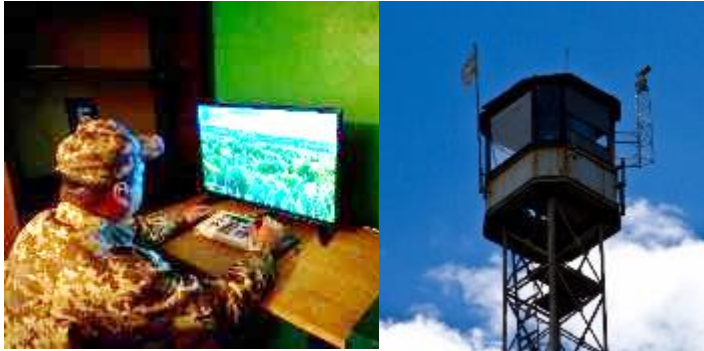
Фото 57, 58. Камера оперативного виявлення пожеж встановлена на 30-ти метровій спостережній вежі та диспетчерський пункт
