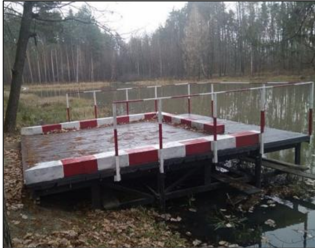
Рис. 26. Приклад облаштування водозабірної площадки з поглибленням дна на березі ставка
