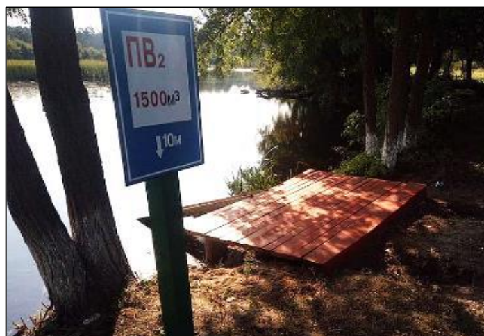
Рис. 28. Приклад облаштування пожежної водойми на березі озера з розміщенням спеціального інформаційного знаку відповідно до ДСТУ (ДСТУ 3534-97, 1997)
