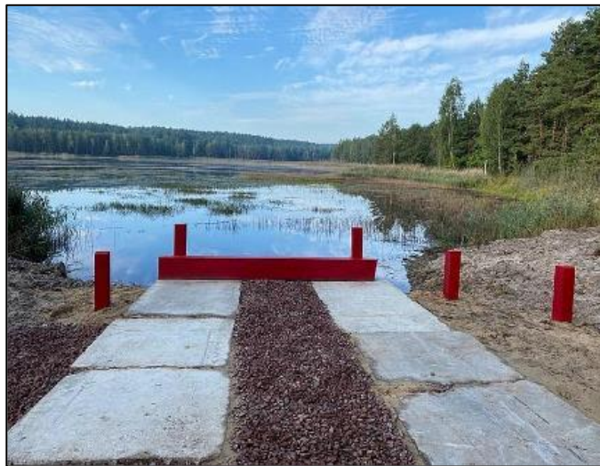
Рис. 27. Приклад облаштування водозабірної площадки з поглибленням дна на березі озера
