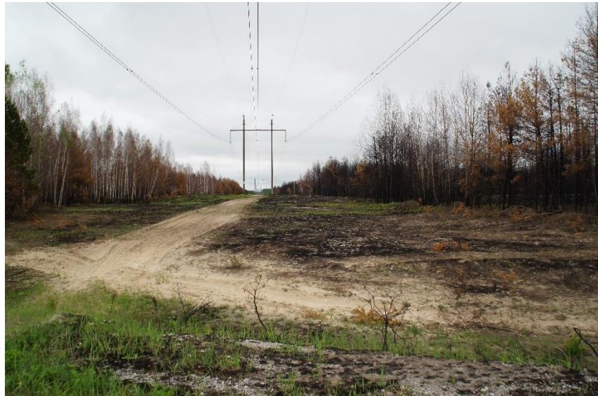
Рисунок 12 - Пожежа у квітні 2015 р. перетнула ґрунтову дорогу та ЛЕП - протипожежний бар'єр без горючих матеріалів шириною до 15 м .
