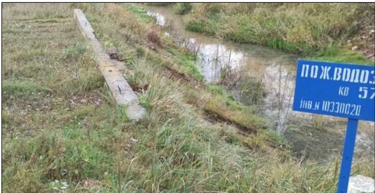
Рис. 2.18. Майже висохла пожежна водойма (51° 26'53,8 "N 30° 07'46,2"E)
