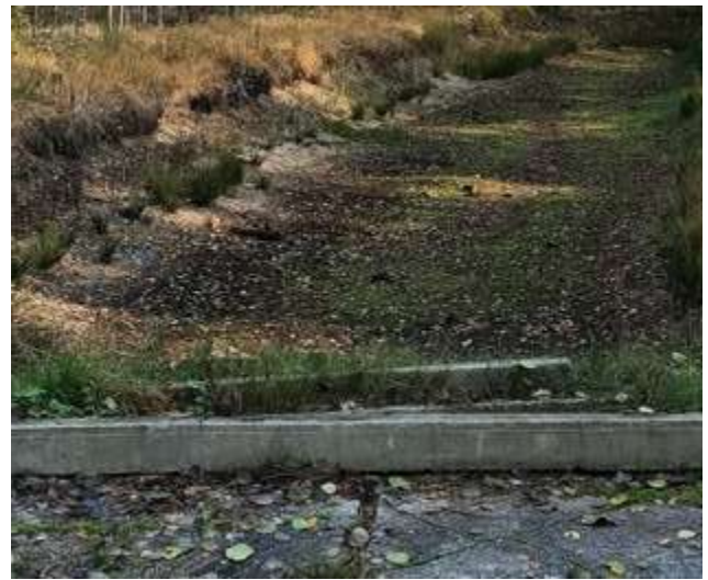
Рис. 2.17. Облаштована під'їздом, пересохла протипожежна водойма (51° 21'32,1 "N 29° 27'00,1"E)
