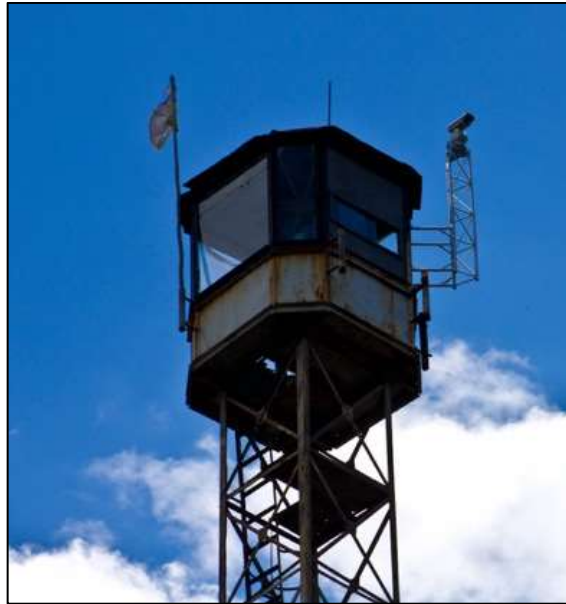
Рис. 2.58. Зовнішній вигляд ПСВ на якій встановлено камеру відео нагляду
