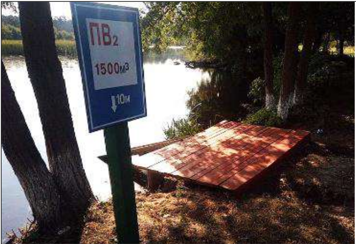
Рис. 2.21. Приклад облаштування пожежної водойми на березі озера з розміщенням спеціального інформаційного знаку відповідно до ДСТУ (ДСТУ 3534-97, 1997)
