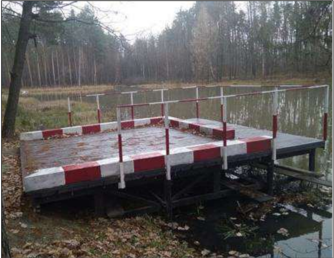
Рис. 2.19. Приклад облаштування водозабірної площадки з поглибленням дна на березі ставка
