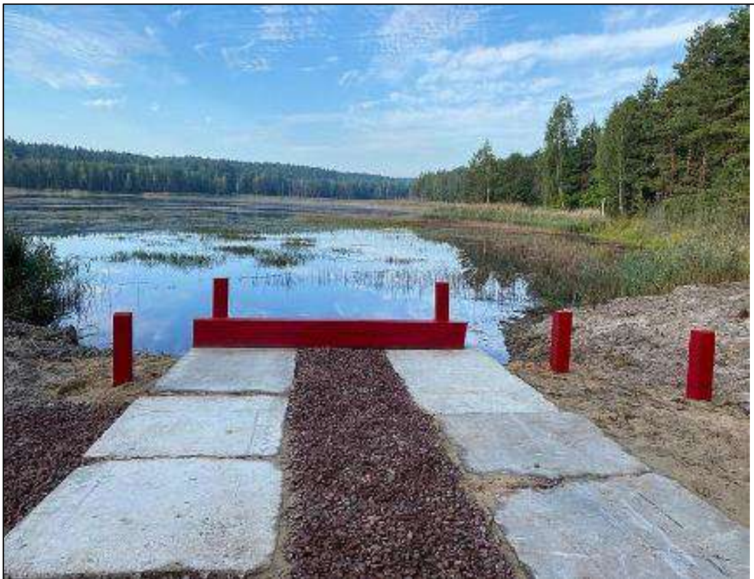
Рис. 2.20. Приклад облаштування водозабірної площадки з поглибленням дна на березі озера
