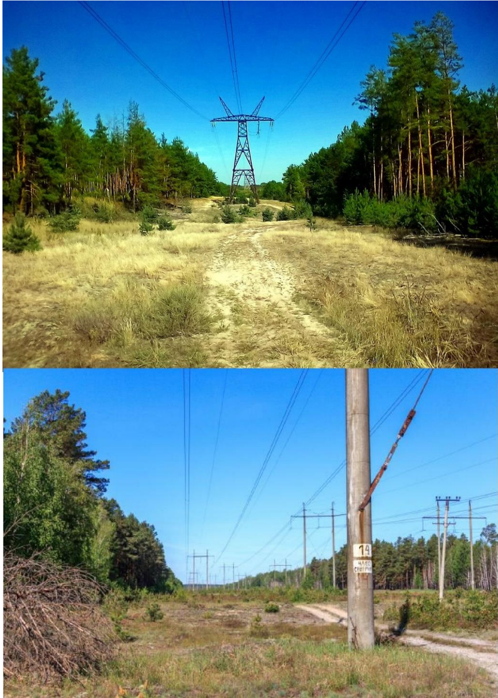
Рисунок 1. Просіки ліній електропередачі
