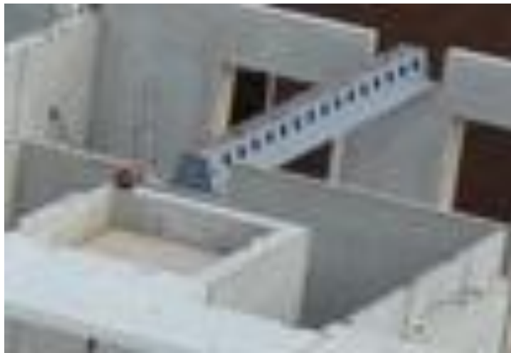
Рис. 1. Установка сталобетонної балки в крупнопанельній будівлі з подальшим монтажем на балку порожнистих плит [1].
