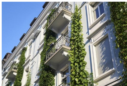
Рис. 5.14. Готель Alma оформлений мотузковою системою Jakob GreenTrellis, Цюрих (Швейцарія) (Jakob Rope Systems, 2022)
