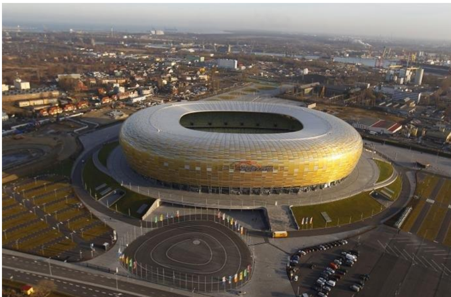
Рис. 1.9. Стадіон PGE Arena Gdańsk*
