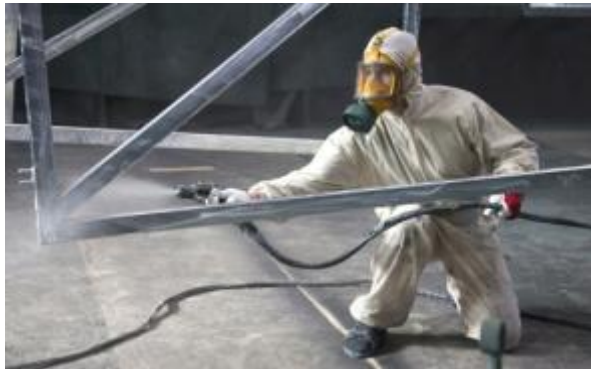
Рис. 1. Нанесення лакофарбового покриття
