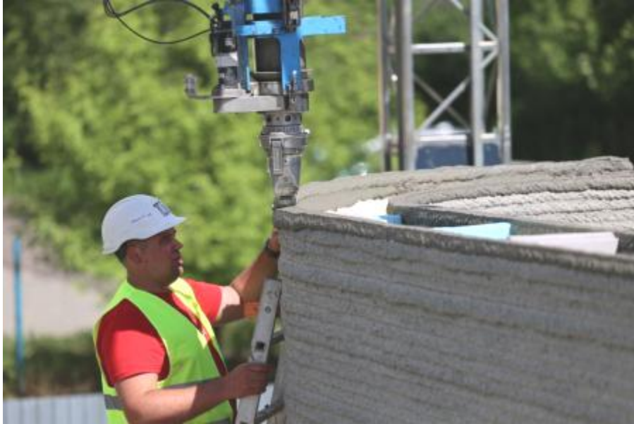
Рис. 1 Будівництво навчального закладу у Львові
