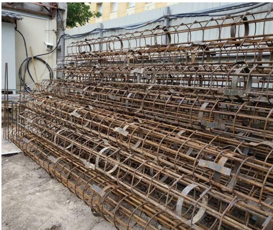
Рис.1 Зовнішній вигляд просторових арматурних каркасів.
