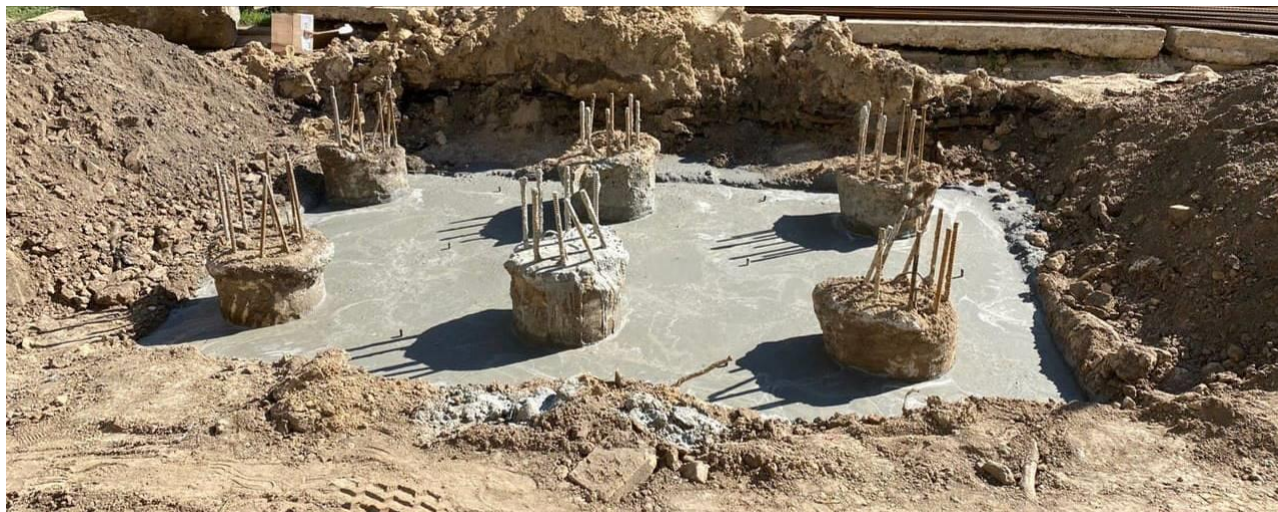
Рис.2 Зовнішній вигляд оголовків паль.
