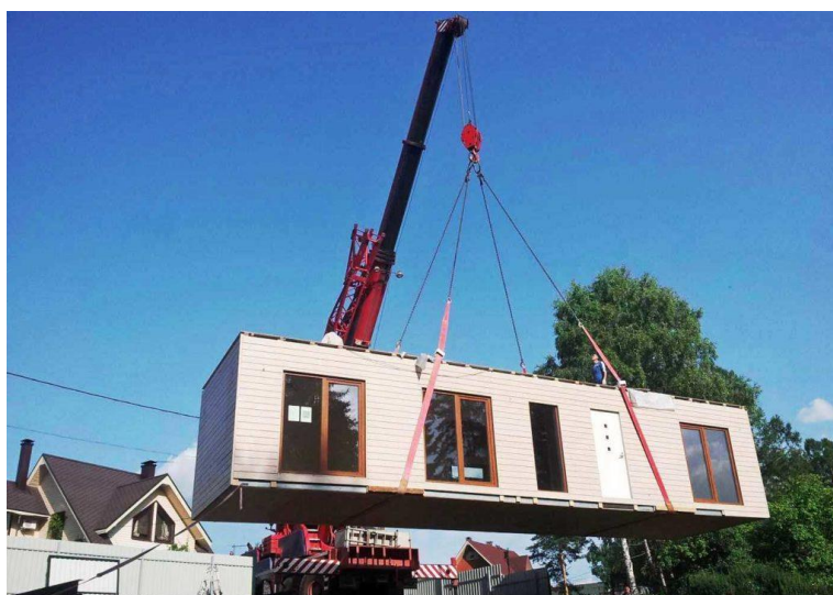
Рисунок 1 – Приклад монтажу модульного будинку
