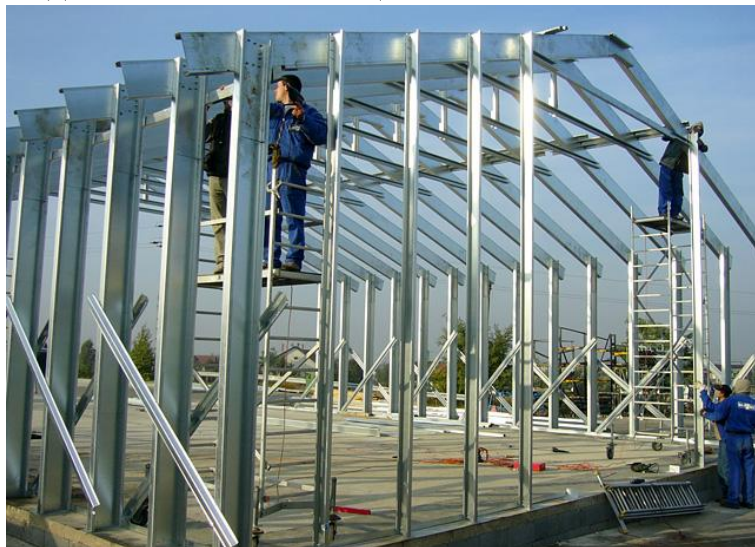
Рис. 1. Металевий каркас одноповерхової будівлі.
