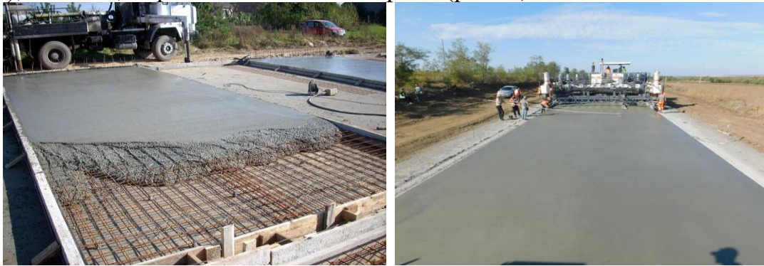
Рис. 2. Застосування полімерцементного бетону
