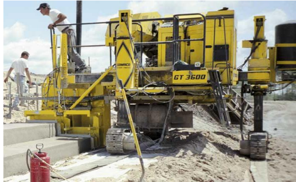
Рис. 6. Самохідний бетоноукладач GT-3600
