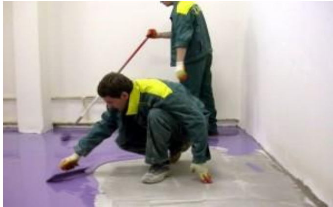
Рис. 2. Нанесення кольорового базового шару
