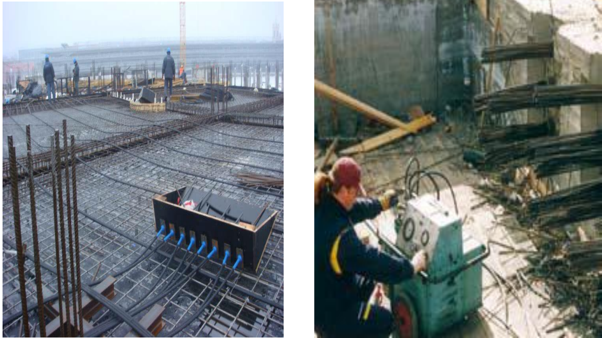
Рис.1. Приклад попереднього напруження армування
