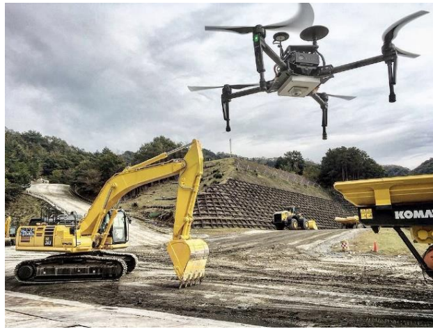
Рис. 1. Нагляд за роботою на будівельному майданчику
