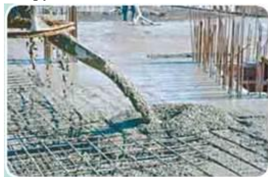
Рис. 2. Фрагмент заливки монолітного залізобетонного перекриття із важкого бетону
