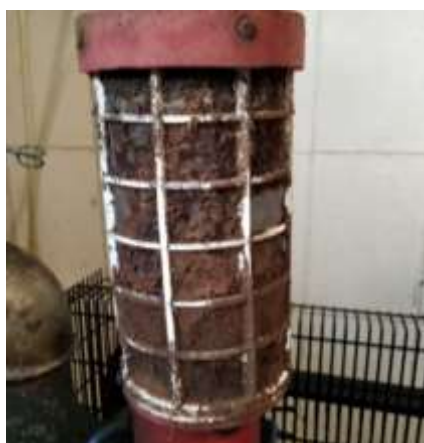
Фільтр пастка ресивера вакуумного насоса
