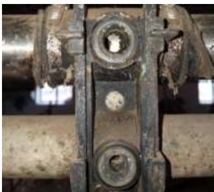
Зміщення отвору молочного крана за рахунок зміщення труб
