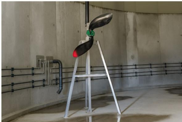
Рис.1.1. Розташування внутрішніх трубчастих теплообмінників і швидкохідної пропелерної мішалки
