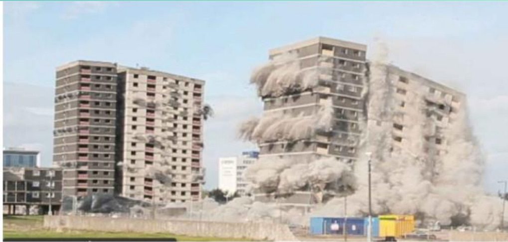
Руйнування будівлі вибуховим методом
