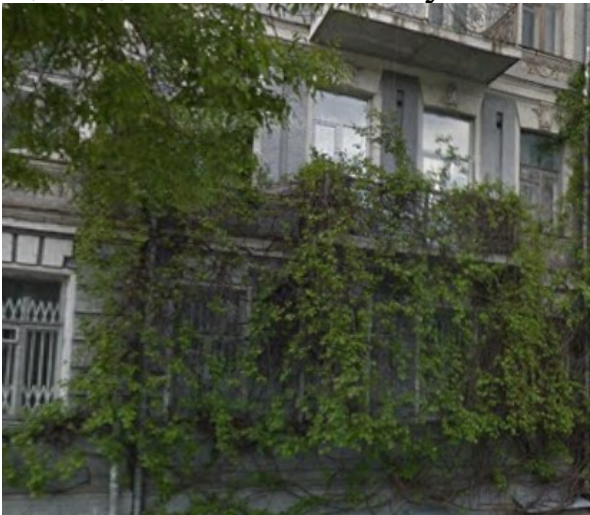
Рис. 1. Озеленення фасаду житлового будинку (вул. Симона Петлюри, б. 2/4, фото автора)
