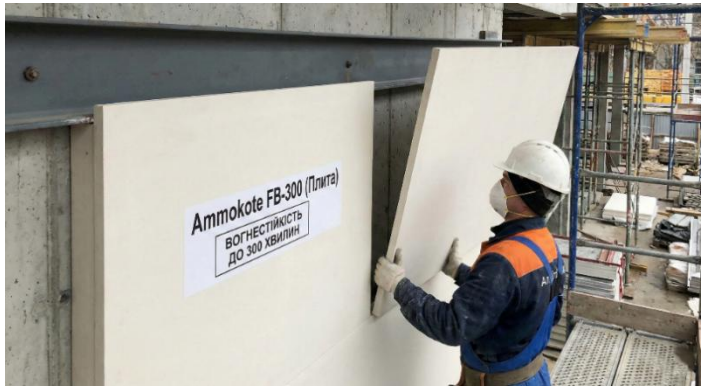
Рис. 3. Монтаж вогнезахисних плит
