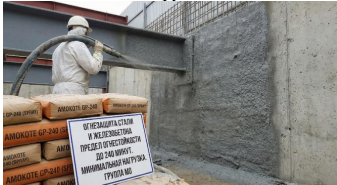
Рис. 1. Механізоване нанесення вогнезахисного покриття
