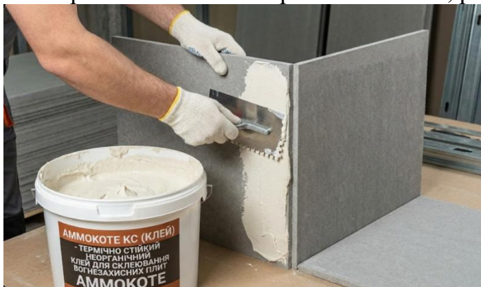
Рис. 6. Нанесення вогнетривкого клею для плит
