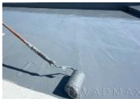
Рис. 2. Фрагмент нанесення гідроізоляційної мастики на поверхню
