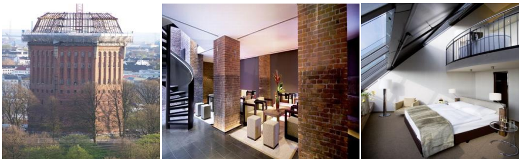
Рис. 3. Конверсія водонапірної вежі з великою ємністю резервуара під готель «Mövenpick» в м. Гамбург
