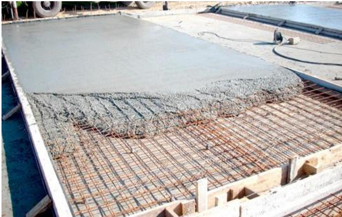
Рисунок 1 – Монолітна плита перекриття
