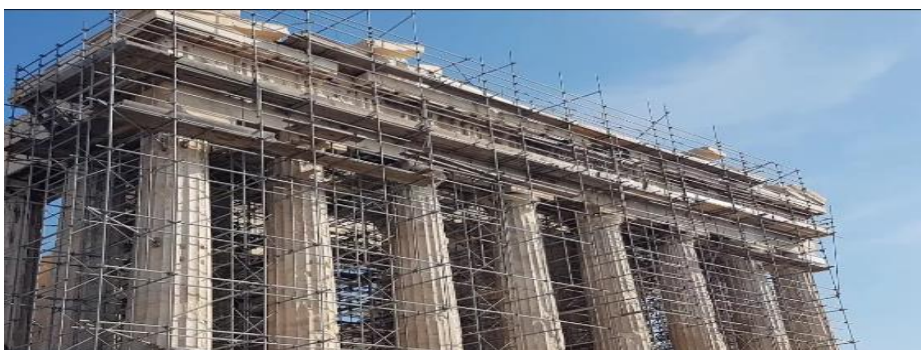
Рисунок 2 – Армування конструкцій будівлі
