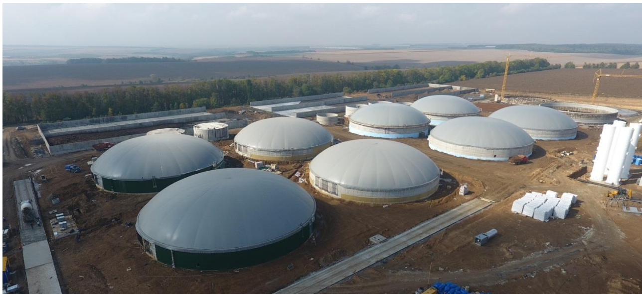
Рис. 1.3. Загальний вигляд будівництва першої біогазової станції на птахофабриці «Оріль-лідер» у Дніпропетровській області
