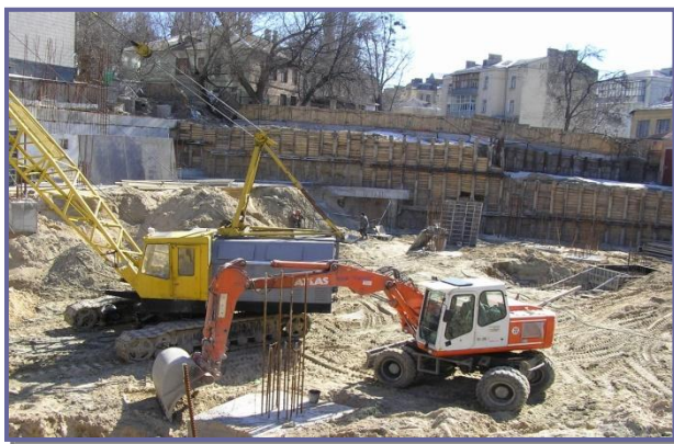
Рис. 1. Фото обгородження котловану при будівництві підземної частини житлового будинку
