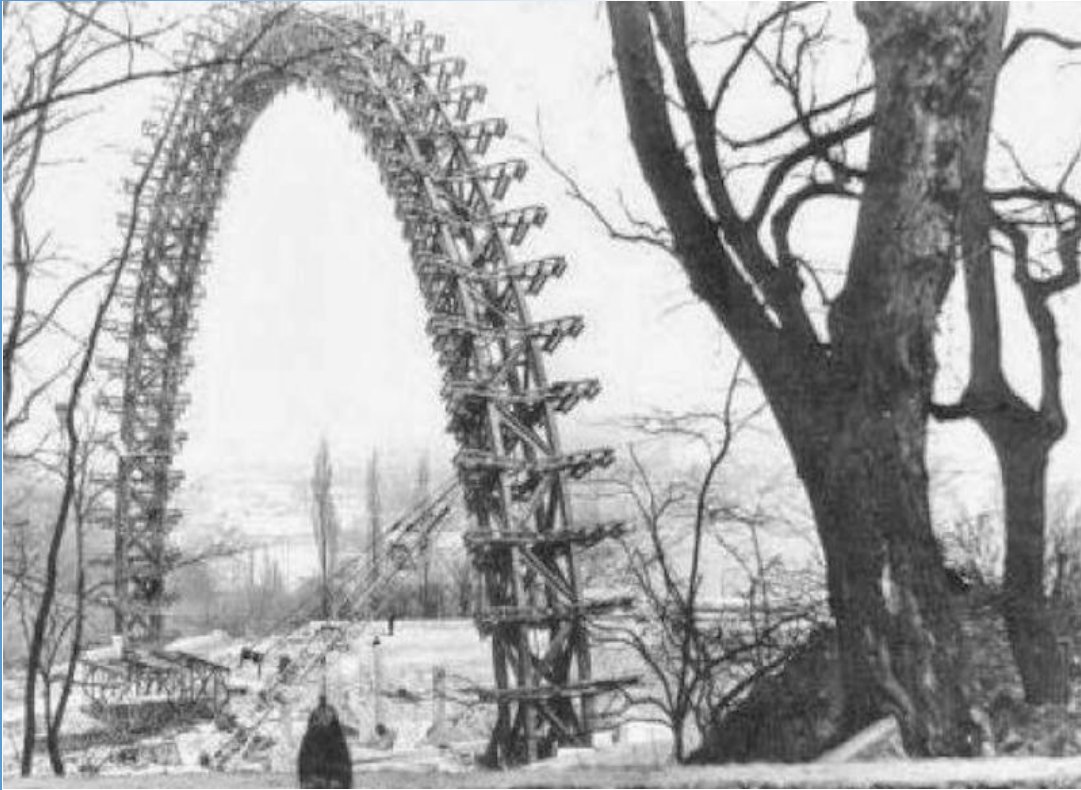
1981 рік. Будівництво арки.
