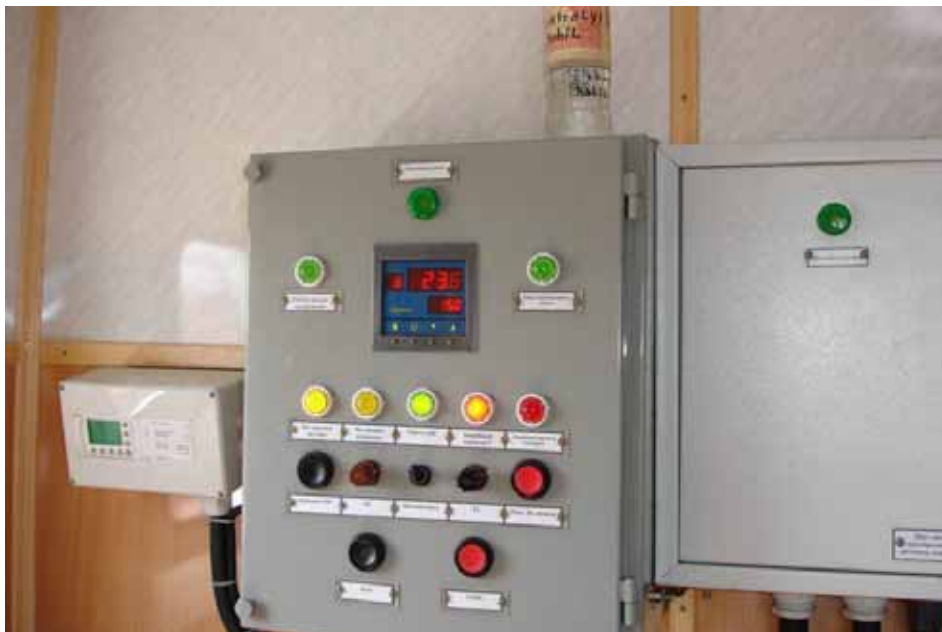
Рисунок 112: Система контроля за температурно-кислородным режимом технологической воды в контейнерах для перевозки молоди (Чепуркина и др., 2008).
