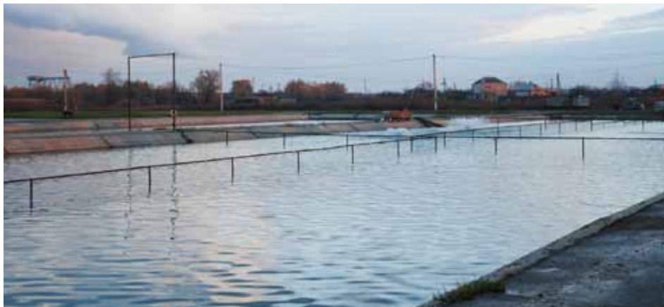
Рисунок 52: Бетонированные разделённые пруды для зимовки и выдерживания производителей с секциями для раздельного содержания.
