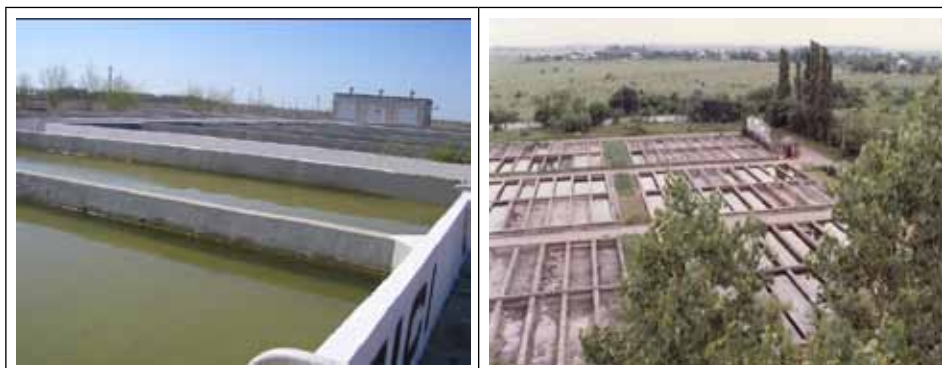
Рисунок 99: Бетонные бассейны для культивирования ветвистоусых (дафний и мойн).
