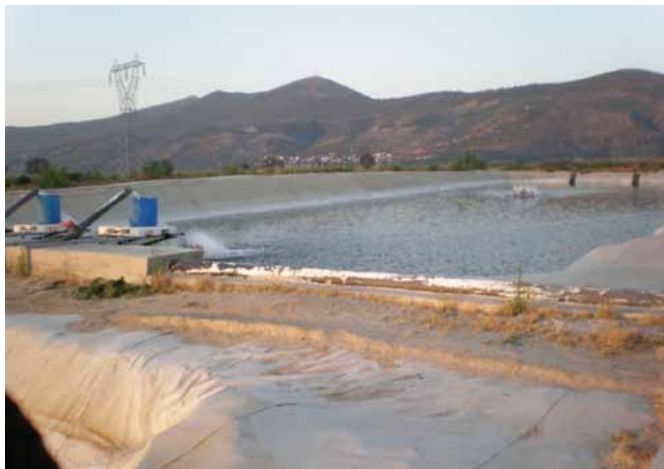
Рисунок 28: Земляные пруды с покрытием ложа геомембраной.
